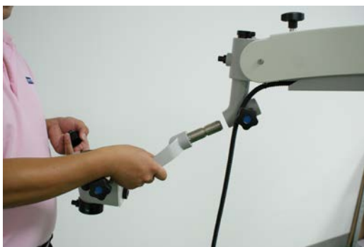
Рис.10 Монтаж третьего плеча
